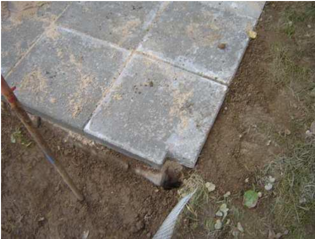
Bodenplatte mit ausgeklinkter Ecke für Einschlaghülse.
